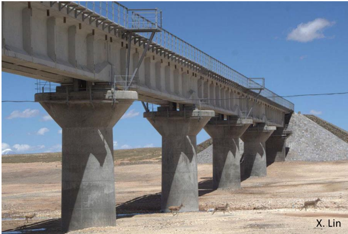
Рис. 27. Мост, построенный на пересечении дна реки, используется мигрирующими антилопами хиру вдоль Тибетской железной дороги.
